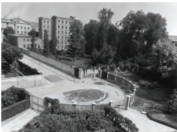
La foto ci mostra la costruzione di via Necchi. La strada non era ancora asfaltata
